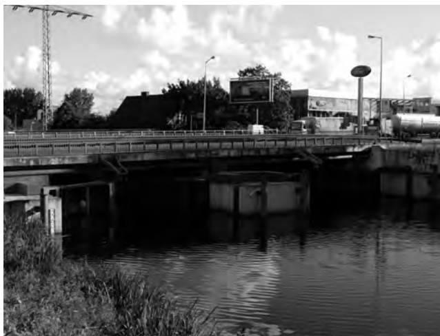
Wrota Żuławskie pod mostem na ul. Elbląskiej w Gdańsku. Fot. M. Opitz
