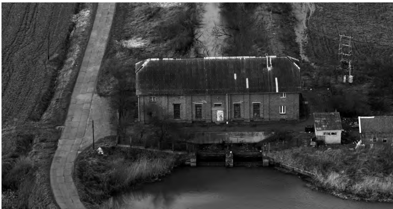
Pompownia Nr 6W Grochowo. Fot. M.Opitz.
