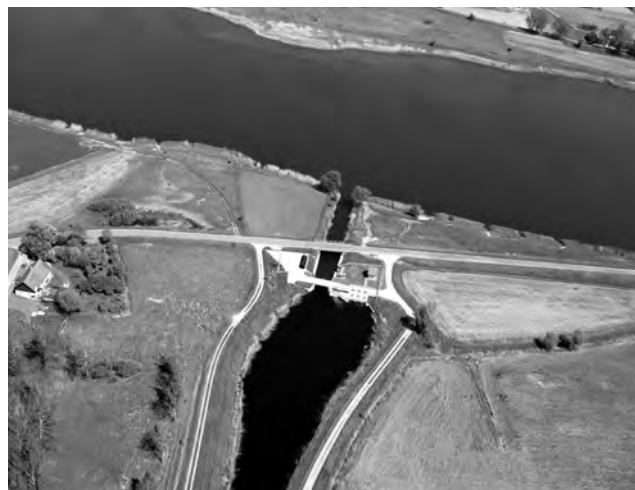
Węzeł hydrotechniczny polderowego systemu Trójkanałów w Trzcinisku Fot. arch. Gminy Cedry Wielkie.
