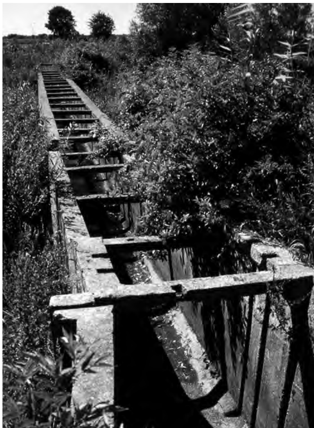
System nawadniania wybudowany na początku lat 70. w okolicach Gozdawy. Woda z Tugi poprzez zastawkę upływała do przegrodzonego w poprzek wałem dawnego Kanału Młynskiego (fragmentu dawnego wodnego połączenia Wisła-Zalew Wiślany) skąd poprzez kolejne zastawki oraz akwedukt nad kanałem melioracyjnym mogła zasilać wodą rowy na Polderze Marzęcińskim, stanowiąc doskonałe nawodnienie pól uprawnych. Fot. M. Opitz
