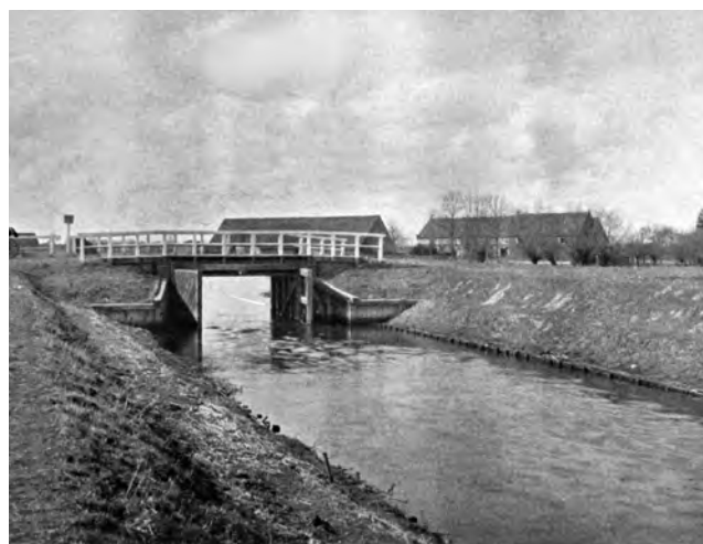
Wrota przeciwsztormowe przy moście na Kanale Śledziowym. Stan z 1906 roku. Źródło: „Die Entwicklung...”
