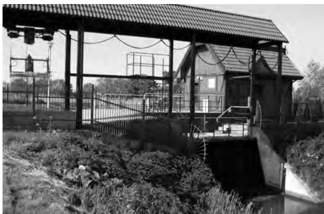
Pompownia nr 53 polderu Nowotki. Fot. M. Opitz
