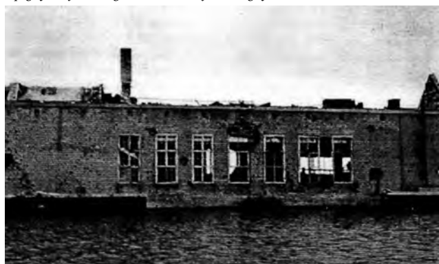
Ruiny pompowni Osłonka po zniszczeniu w 1945 roku.
