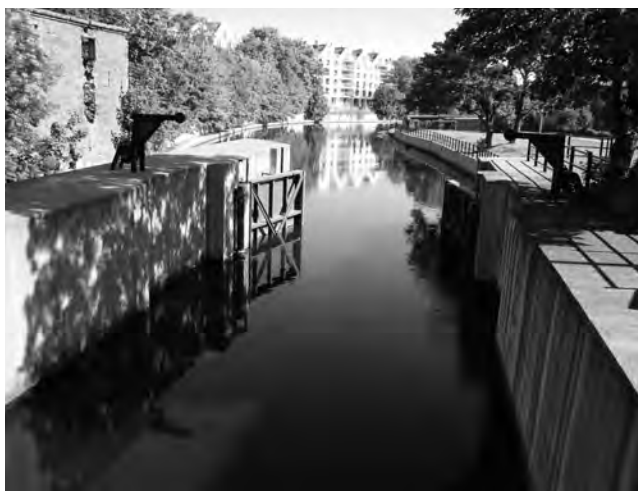
Wrota przeciwpowodziowe Kamienna Grodzka stan w 2010 r. Fot. M. Opitz.
