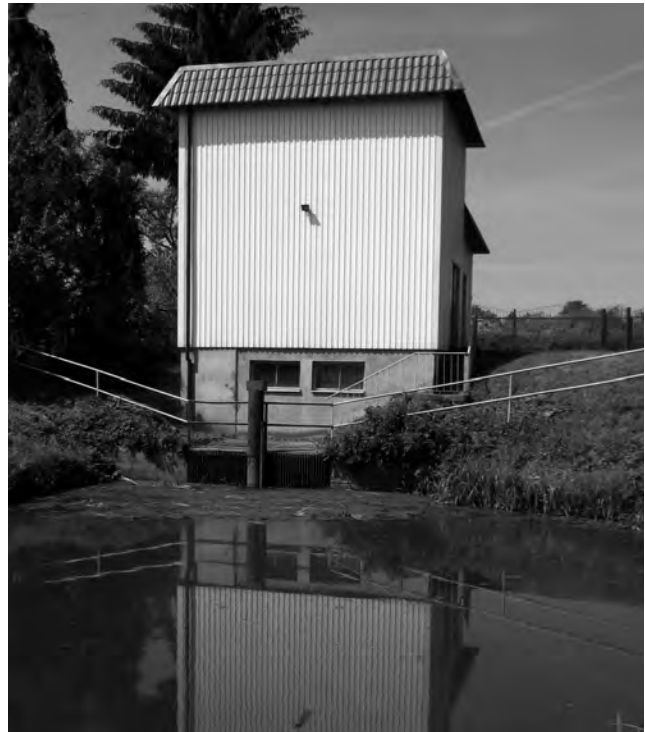
Pompownia nr 70 Wężina.
