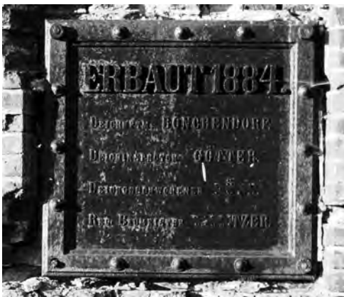
Tablica upamiętniająca rok budowy i nazwiska osób związanych z powstaniem wrot przeciwsturmowych i śluzy w Marzęcinie. Fot. M. Opitz
