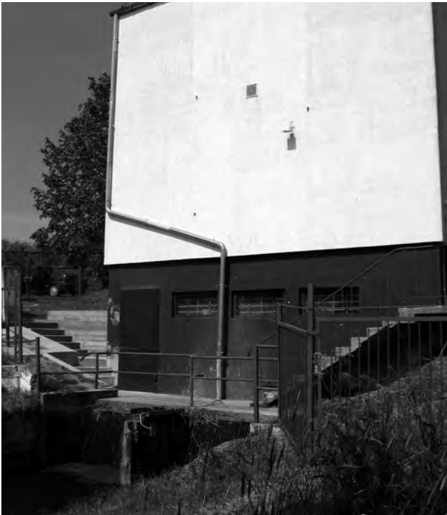
Pompownia nr 71 Dłużyna – Karczma.
