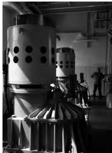
Wnętrze pompowni Osłonka. Fot. M. Opitz
