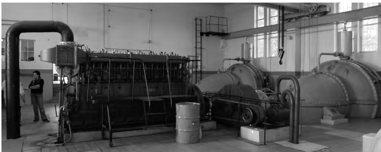
Wnętrze pompowni Chłodniewo. Fot. M.Opitz
