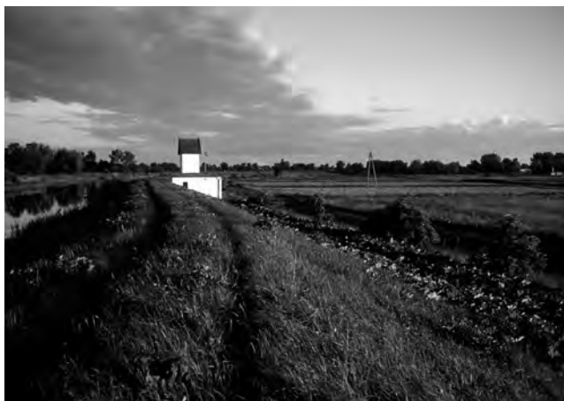
Pompownia nr 27 Raczki Elbląskie. Fot. M. Opitz
