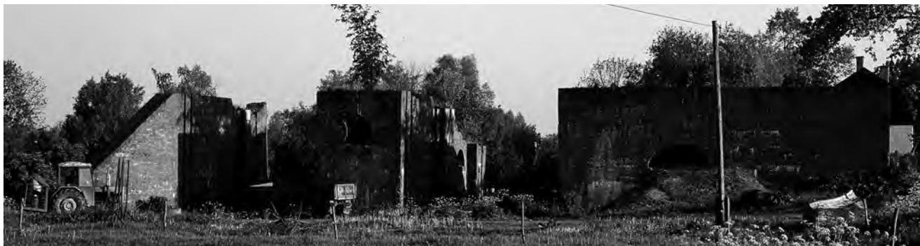
Ruina wrót przeciwsztormowych w byłym wale przeciwpowodziowym w Marzęcinie, zbudowanych w 1884 roku. Fot. M.Opitz
