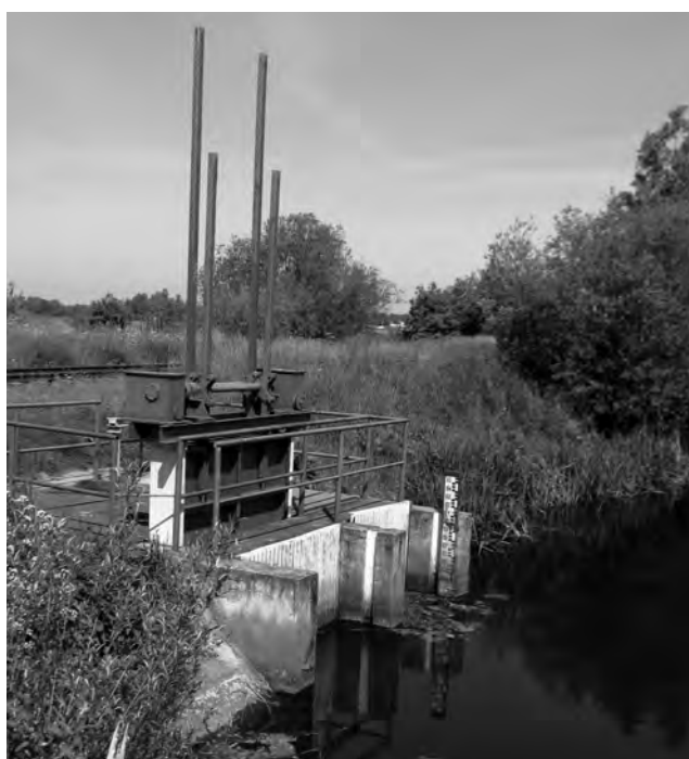
Zastawka w wale rzeki Fiszewki. Fot. M. Opitz
