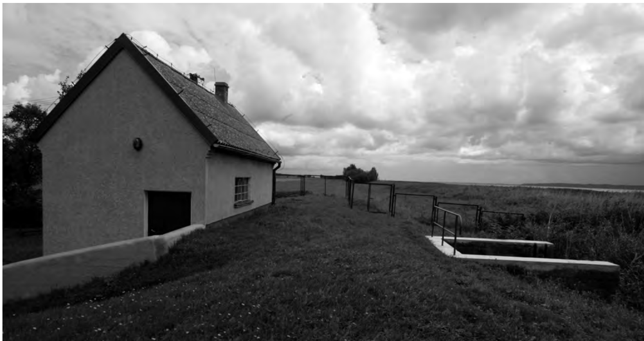
Pompownia Przebrno 69. Fot. M.Opitz
