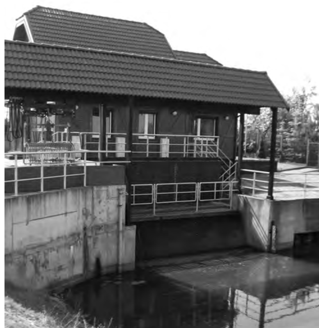
Pompownia nr 36 polderu Nowakowo. Fot. M. Opitz
