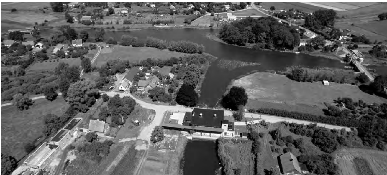
Stacja pomp w Chłódniewie. Fot. M. Opitz
