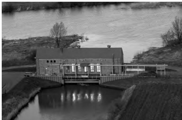
Pompownia Osłonka. Widok od strony wody dolnej. Kanał Paniński. Fot. M.Opitz
