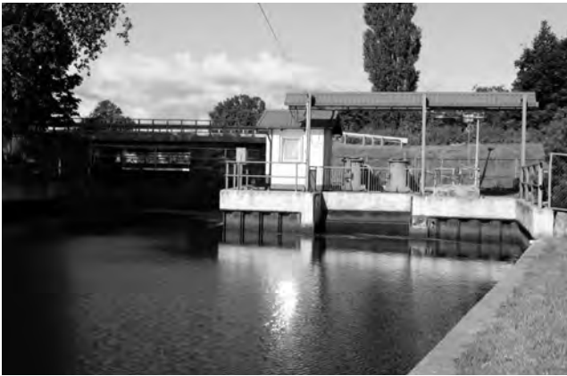
Pompownia sztormowa przy wrotach i moście na Rozwójce przy ul. Sztutowskiej. Fot. M. Opitz
